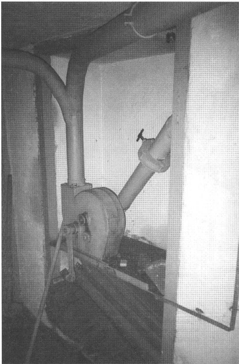
Schron amunicyjny baterii. Powyżej widok od strony wejścia, poniżej wewnątrz schronu, wnęka z ręcznym wentylatorem. © W. Nadolny. Battery ammunition shelter. Above entrance, below interior, niche with hand-operated ventilator.
