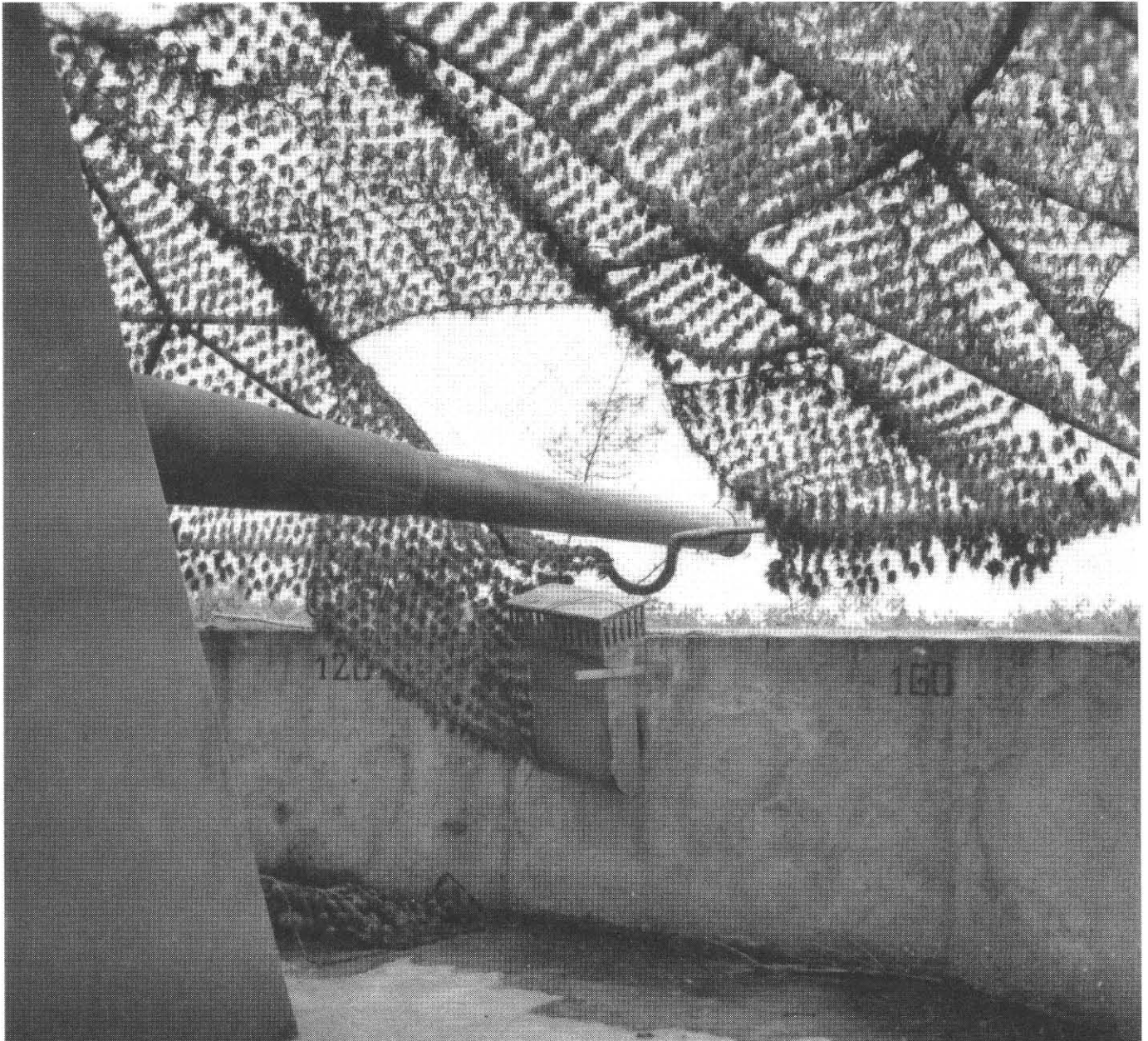
Stanowisko bojowe baterii im. H. Laskowskiego po walkach w 1939 r. Widok spod parasola maskującego, na przedpiersiu wylot kominka wentylacyjnego. Il. zbiory Autora.
